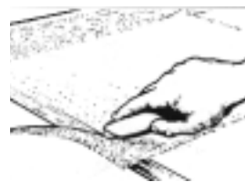
Bruk en skarp kniv til å fjerne overskuddet av glassfiberduken
